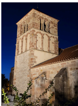
Rénovation de l'éclairage public p. 4
